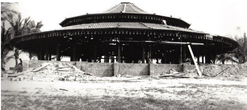
Figura 4. Construção do Clube Jacarandá
