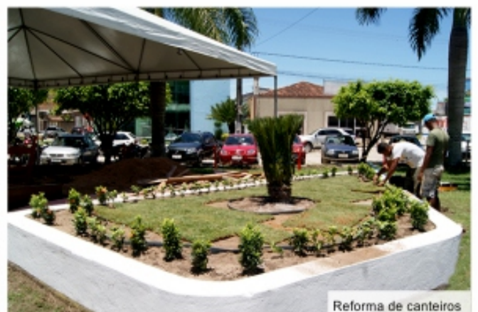
Reforma de canteiros
