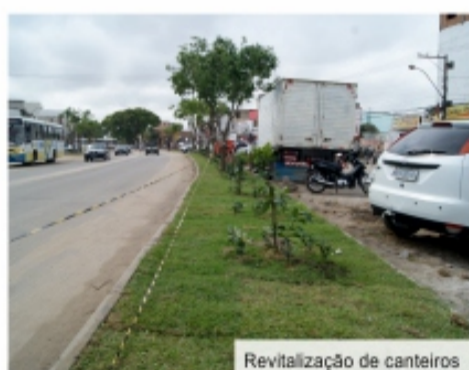
Revitalização de canteiros
